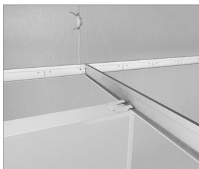
Rockfon Universal Baffle korrekt fastgjort til en Chicago Metallic T24 profil (begge kanter klikket på T24 profilens kant).
